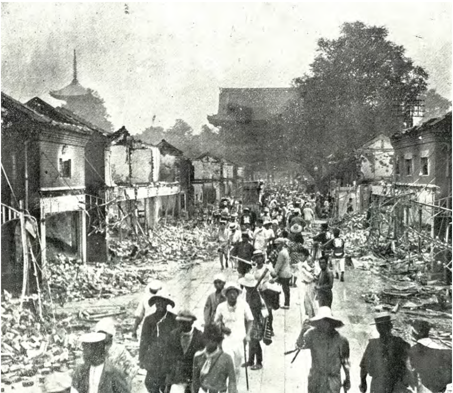
Efectos de Gran terremoto de Kantō. Destrucción en el área de Sensō-ji temple in Asakusa. Fuente: Wikipedia, diario Osaka mainichi.
